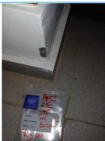
Matériaux : P057 Prélèvement : P057 Description : béton gris colle grise sol soubassement Localisation : RDC Résultat : Absence d'amiante
