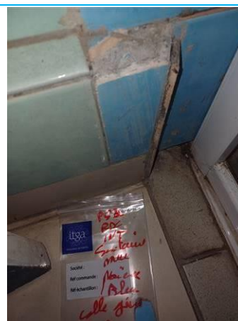
Matériaux : P052 Prélèvement : P052 Description : faïence bleu colle grise Localisation : RDC - sanitaire Résultat : Absence d'amiante
