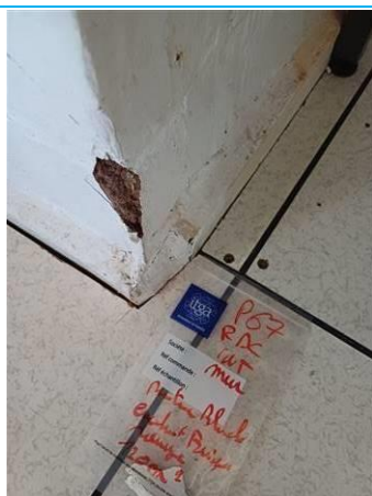
Matériaux : P067 Prélèvement : P067 Description : peinture blanche enduit brique rouge Localisation : RDC Résultat : Absence d'amiante
