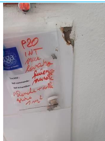
Matériaux : P020 Prélèvement : P020 Description : faïence blanche colle grise Localisation : Demi Palier - mur int lavabo Résultat : Absence d'amiante
